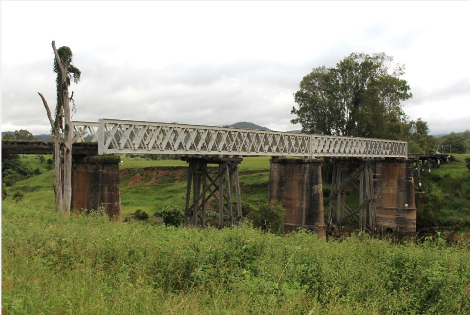
Woolooga Rail Bridge, 2020.
